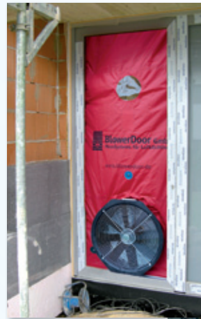
BlowerDoor Messung eines neu gebauten Einfamilienhauses
